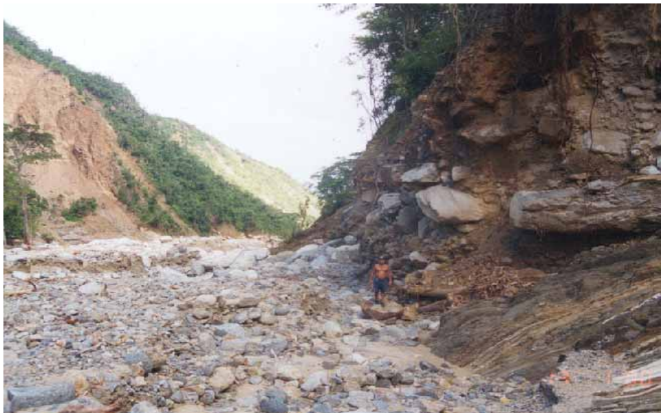
21. Escarpe de suelos coluviales erosionados o socavados por la creciente del río. Véase que dicho material se apoya en el macizo rocoso (esquina inferior derecha).
