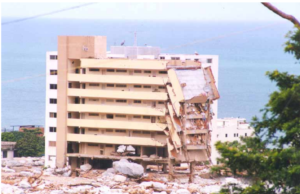
3. Edificio que falló por la incidencia de los arrastres del río.
