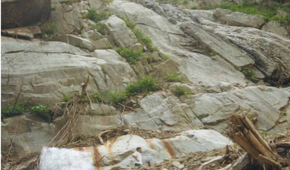
9. En este caso se muestra un talud de considerable altura en una margen del río San Julián. El cauce, al igual que en el caso anterior, es perpendicular a los planos de foliación de la roca y junto con las diaclasas define bloques de grandes dimensiones. Además, en este talud no hay aluvión ni suelos coluviales.
