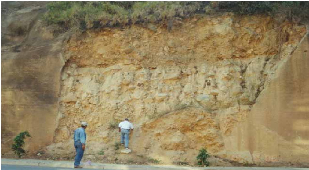
7. Corte de talud Urb. La Llanada. En la fotografía se observan dos capas de sedimentos, la superior un poco más oscura, ambas constituidas por aluvión del río Camurí Chico. Cada capa corresponde a una creciente diferente, probablemente cientos de años entre ellas.
