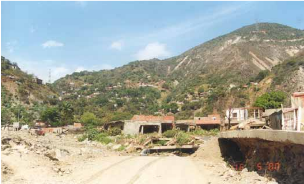
2. Viviendas destruidas por el río Mamo durante las lluvias de diciembre de 1999.
