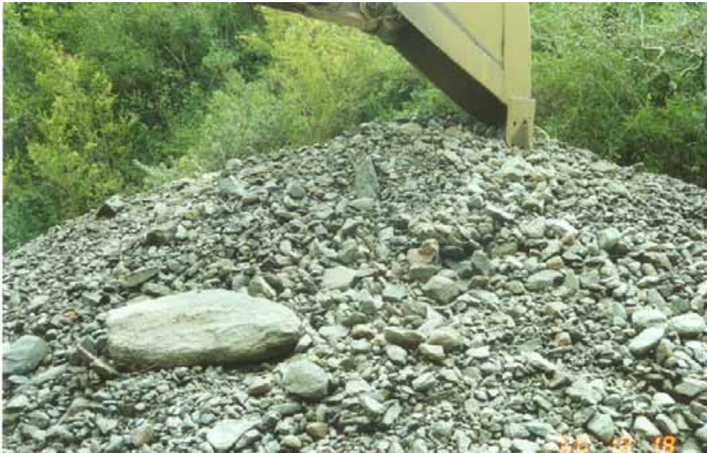
5. Al excavar en el cauce de la quebrada El Tigre encontramos bloques de pequeñas dimensiones, grava, arena y escasa arcilla.
