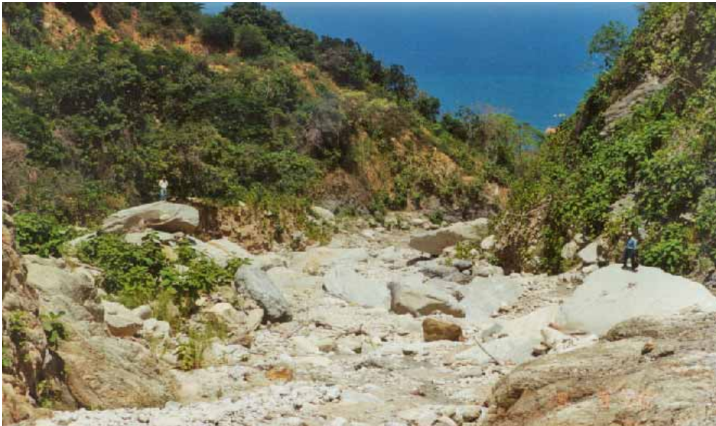
4. Sector socavado del río.
