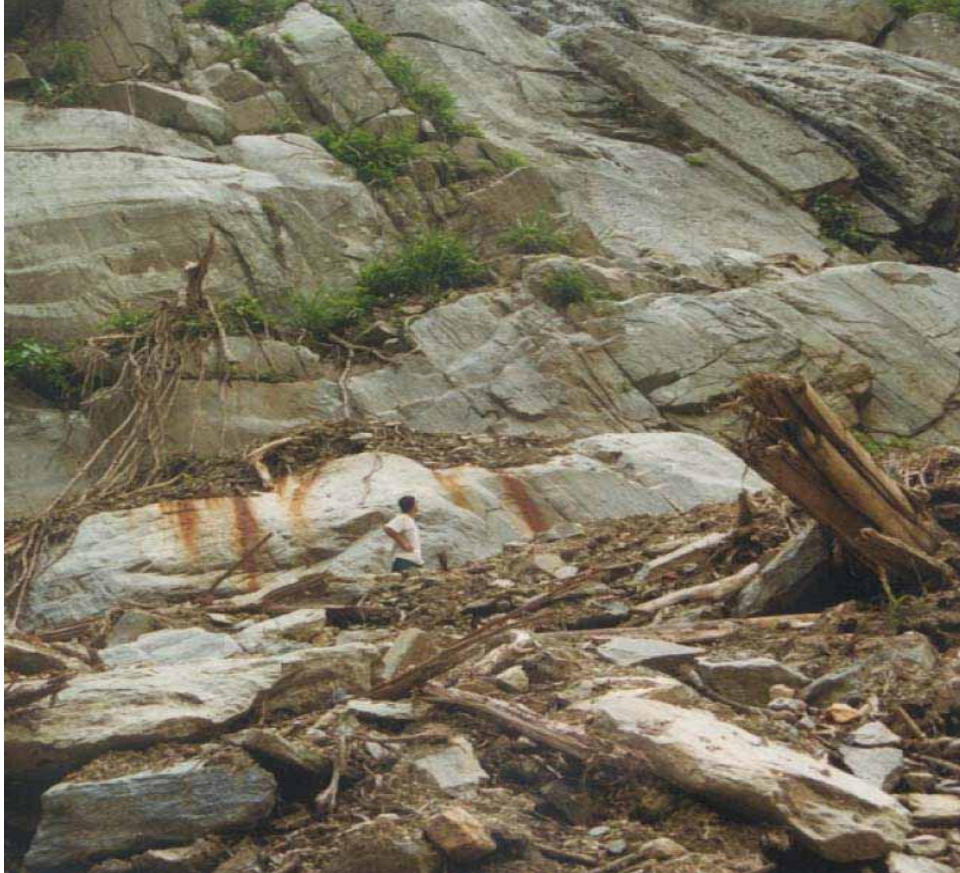
23. Deslizamientos en el macizo rocoso.
