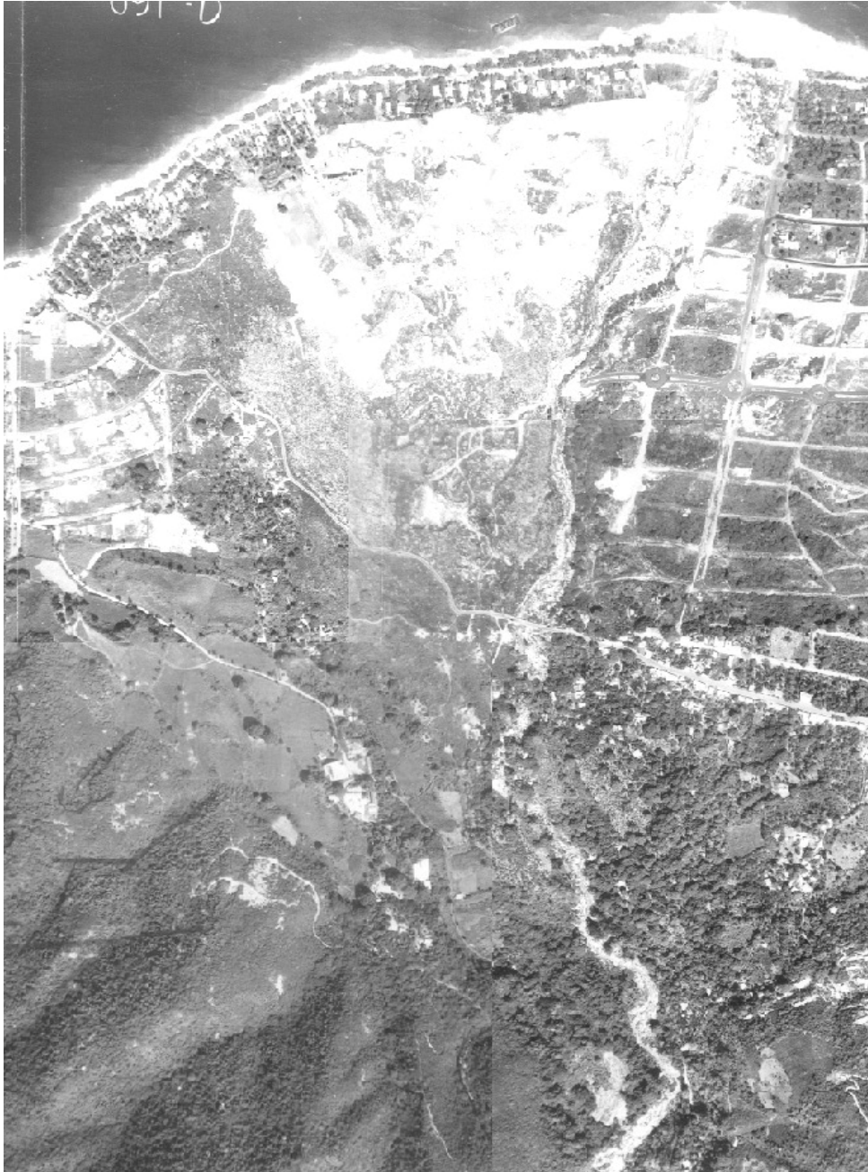
4. Fotografía aérea 1956. Véanse las primeras vías construidas al noreste, destruidas durante las lluvias de 1951. (Cartografía Nacional).
