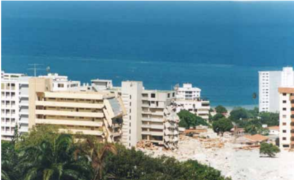
2. Vista panorámica de dos edificaciones colapsadas por el impacto de los enormes bloques, transportados por el río que está a la derecha.
